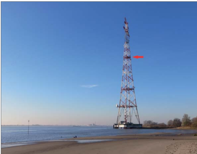
Abb. 1: Der 197 m hohe Freileitungsmast in Hetlingen, in dem die Wanderfalken gebrütet haben. Auf 117 m Höhe (roter Pfeil) befinden sich die Nisthilfen (17.11.2014, A. BRANDT).
